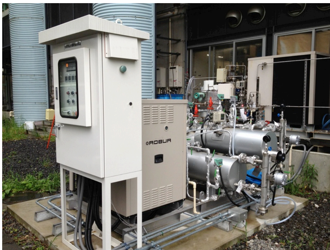
図3.2-1 溶液貯蔵方式実験装置の外観
