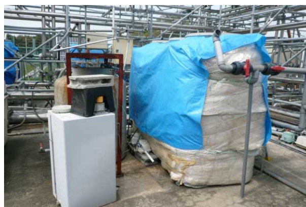
写真8 窒素／リン除去型浄化槽
