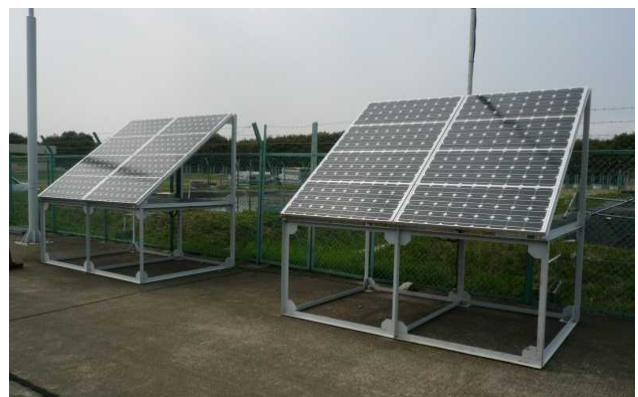
写真2 現場監視端末
