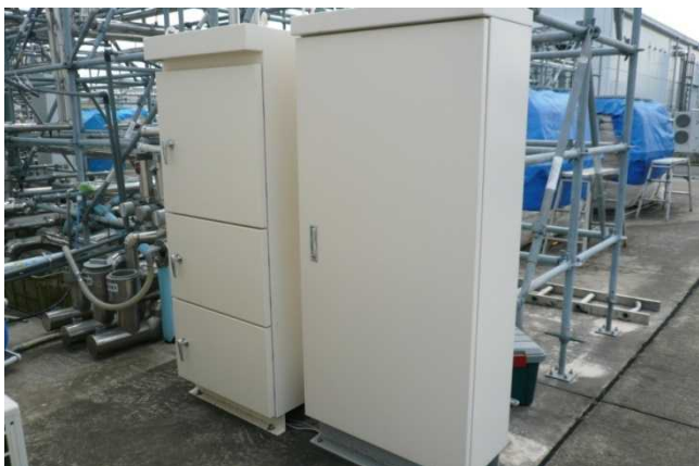
写真3 太陽光風力の電力監視盤
