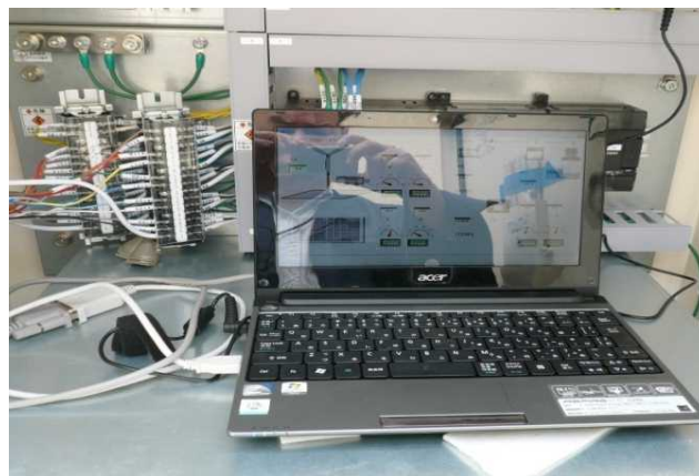
写真4 現場監視端末
