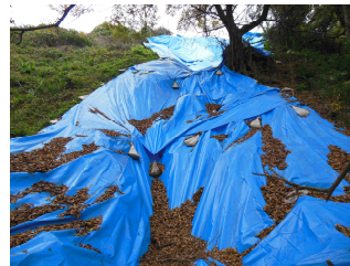
写真 3.1.3 一般廃棄物処分場 (関西現場) での表層崩壊 (停止安息角を上回る 40°の斜面で、破損した U 字溝から降雨時に大量の水が入り崩壊したとみられる。崩壊の幅約 3~10m、奥行き平均 2m、崩壊高 20m。崩壊後の灰等の廃棄物の勾配は停止安息角とほぼ同じ 30°。)
