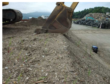
写真 3.2.7 法肩部へのバケット载荷(東北現場)
