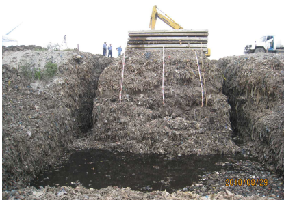
写真 3.5.1 载荷実験（上海） 斜面高 9m、勾配 63.5°、载荷重 8.6 kN/m 2
