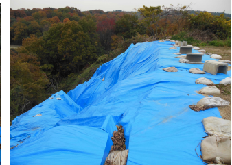
写真 3.1.4 同左・破損した U 字溝を起点とした崩壊
