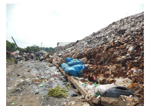
図(5) 生ごみ等の水分や降雨、その他崩壊要因による廃棄物層内でのすべり（主に海外事例）
