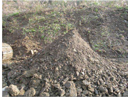
写真 3.2.2 九州現場写真
