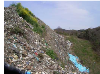
2)① 紐状物、シート状物（繊維状物等）混入多の現場
