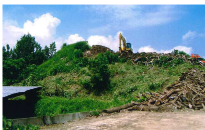
1)① 粗大物主体の現場（角材主体）
