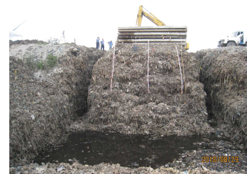
写真 1 載荷実験(斜面高 9m,勾配 63.5°,載荷重 8.6 kN/m 2 )
