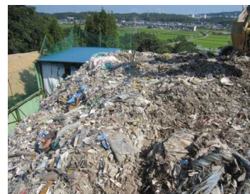
急傾斜面上で法肩に沿ったクラック
