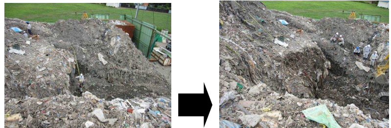
写真 3.5.2 不法投棄等現場(中部①)での崩壊実験 (左写真: 矩形トンネル状の掘削 右写真: 崩壊後)
