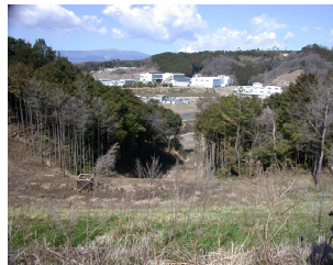
写真 3.1.2 大規模崩壊が生じた傾斜地上投棄地 (崩壊後再投棄された斜面、静岡県三島市)
