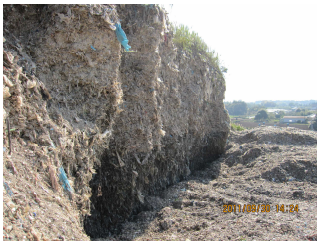
写真 3.1.1 厚さ 1m の表面くずれが生じた直壁 (関東①現場)
