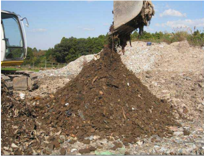
写真 3.2.1 関東①現場
