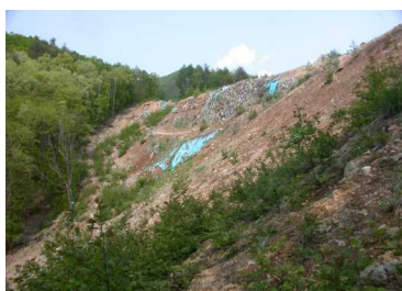
2)② 同・斜面上の投棄現場
