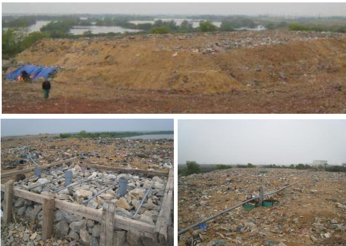
図 6.3.1 DinhVu 埋立地内に建設した「循環式準好気性埋立地」のパイロットプラント
