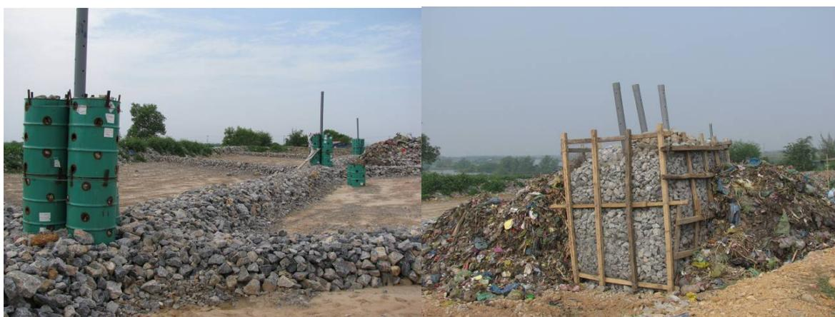
図 6.3.2 廃棄物充填前のパイロットプラントの写真（左：ガス抜き管及び集排水管，右：循環柵）
