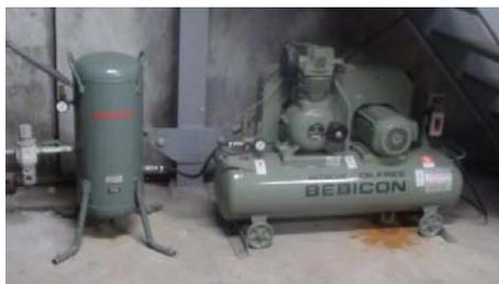
写真-5.2.4 ④ ゲート用コンプレッサー
