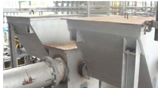
写真-5.3.4 ④ 溶融炉用助材ホッパ
