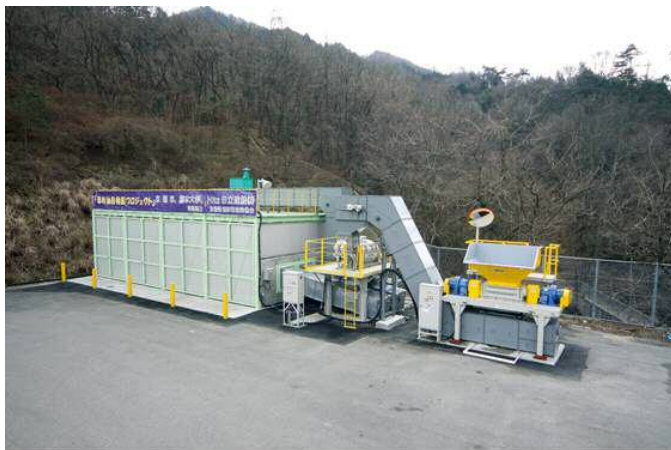
図 1-1 実証設備全景 (受入貯留・破碎分別エリア)
