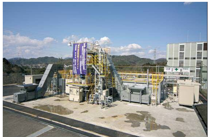
図 1-2 実証設備全景 (エタノール変換処理エリア)
