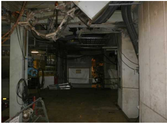
写真 37 大塊コンベヤ解体
