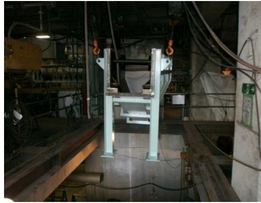
写真 26 新規水砕ピット取込み
