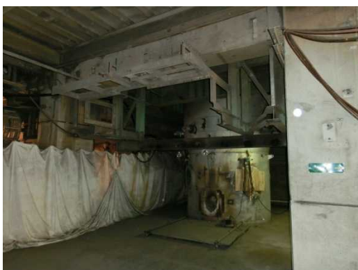
写真11 溶融炉解体前
