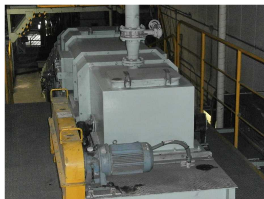
写真 45 NO.6 副資材コンベヤ
