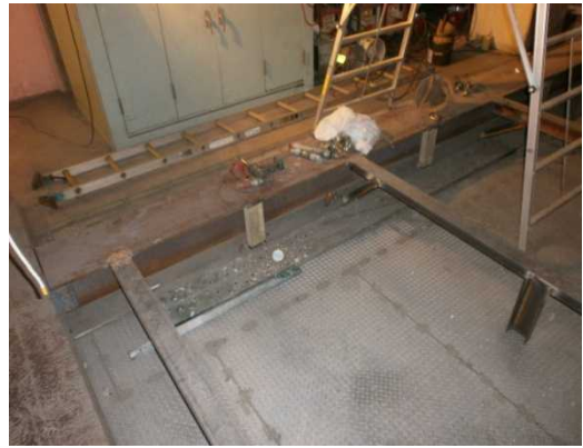
写真 32 本体取込み準備（レール補強）
