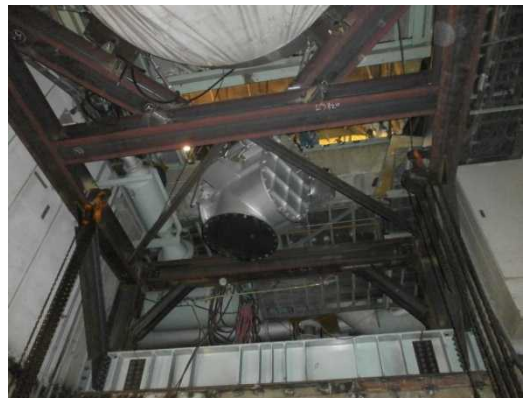
写真 34 副資材シール弁上架
