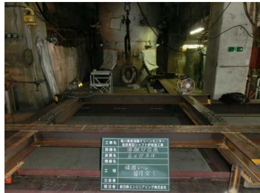
写真10 1階仮設レール組立
