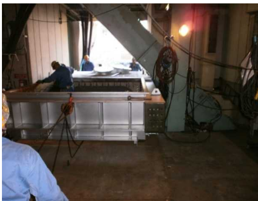
写真 35 低炭素型シャフト炉上部取込み
