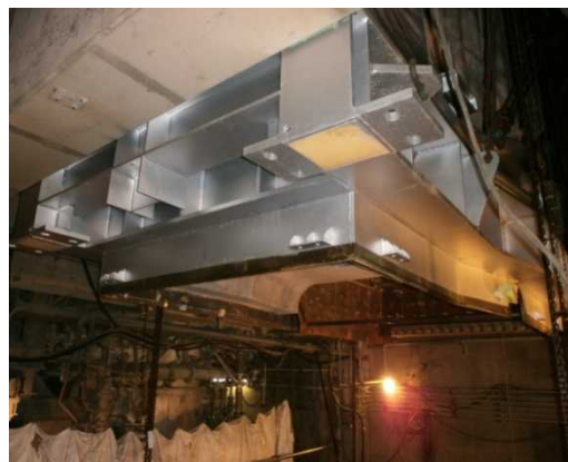
写真 36 低炭素型シャフト炉本体上部仮吊り
