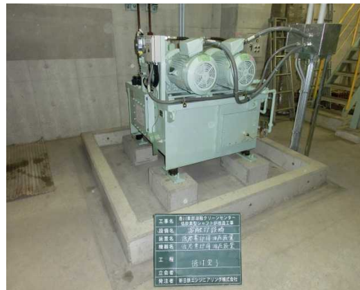
写真 49 低炭素型シャフト炉用油圧装置
