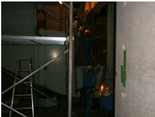
写真 23 水砕ピット解体
