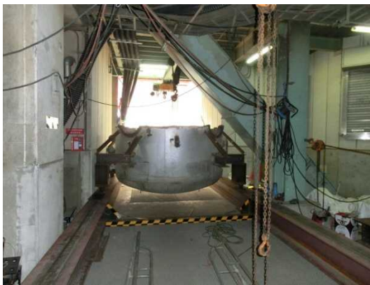
写真 15 炉底搬出
