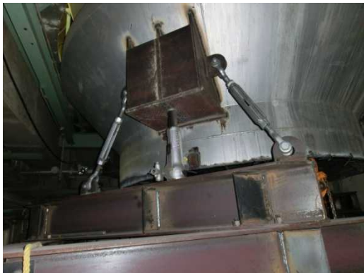
写真9 溶融炉仮固定用ブラケット
