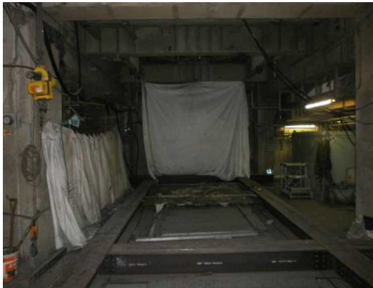
写真 21 既設炉解体完了
