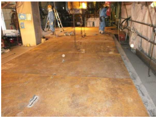
写真 33 本体取込み準備（敷鉄板敷設）
