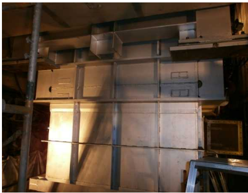
写真 39 本体・上部溶接完了
