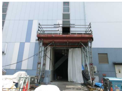
写真 6 仮設部材取込用構台
