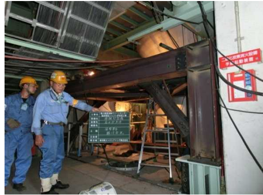
写真8 2階仮設架台組立
