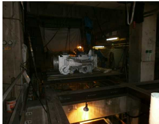
写真 28 トロップ灰排出2重シール弁取込み
