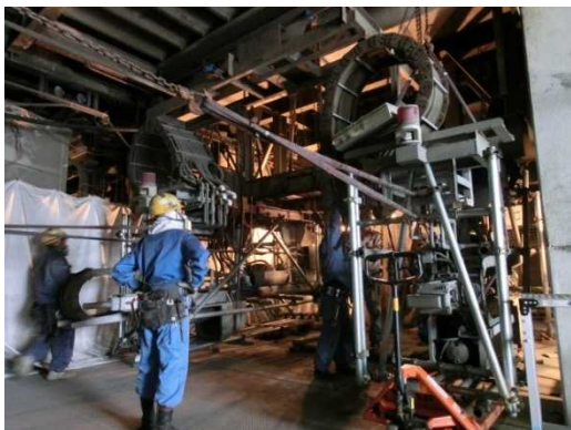
写真 3 出湯口開閉機解体・移設
