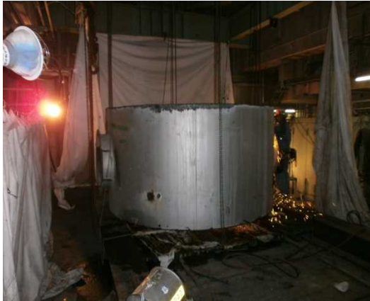
写真 19 シャフト上部解体
