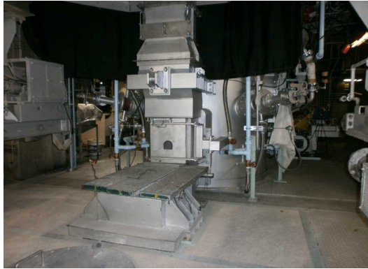
写真 40 低炭素型シャフト炉本体 （出湯口（炉底部））
