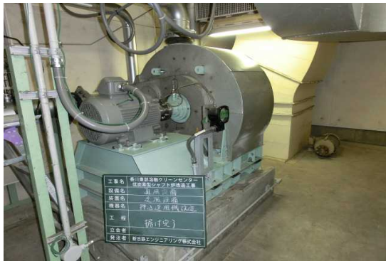
写真 46 押込送風機 (上段羽口送風機を改造)
