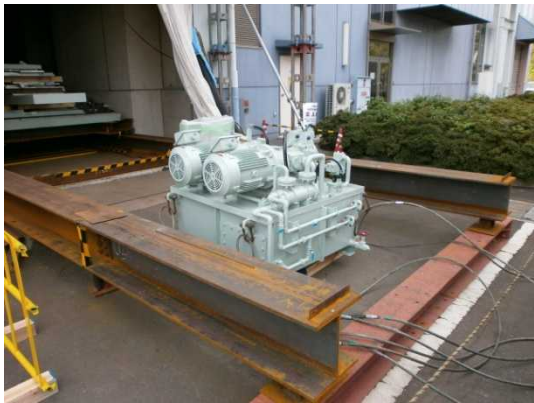
写真 27 油圧ユニット取込み
