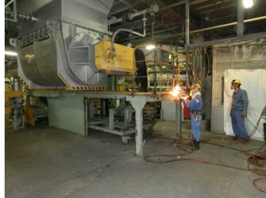
写真 2 燃烧室ダスト排出装置デッキ改造
