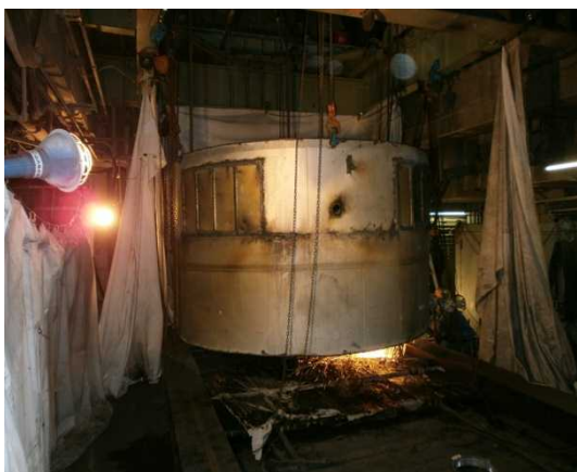
写真 17 シャフト下部解体
