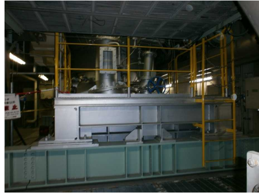
写真 41 低炭素型シャフト炉本体 （炭化物供給装置およびシャフト部）
