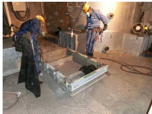
写真 4 上段羽口送風機取外し
