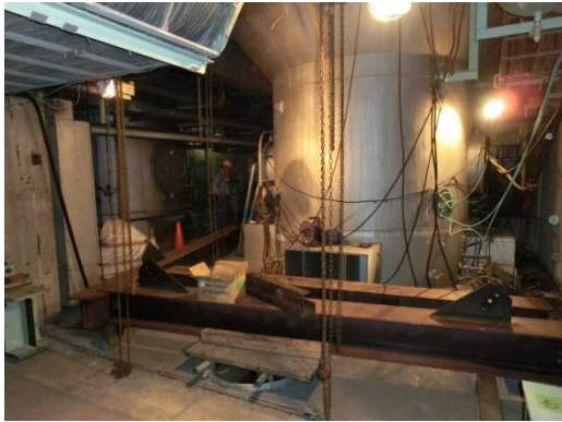
写真7 2階仮設部材取込み
