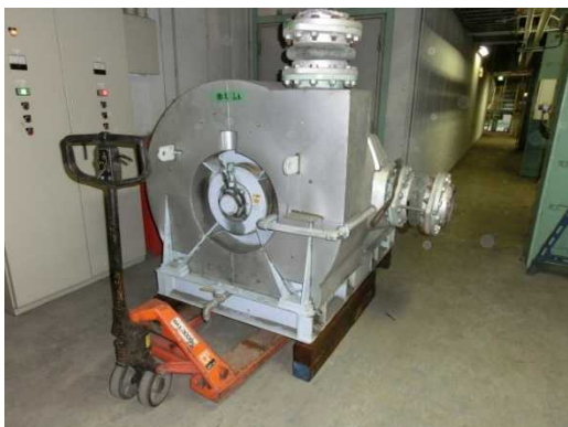
写真 5 上段羽口送風機搬出
