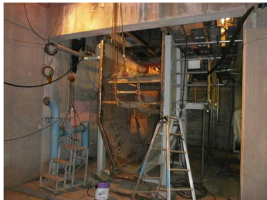
写真 24 水砕ピット解体完了
