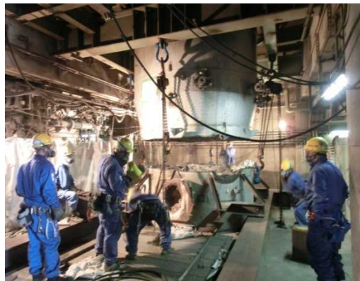
写真 14 炉底吊り上げ
