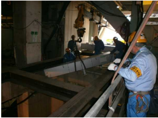
写真 25 トロップ灰搬送コンベヤ取込み
