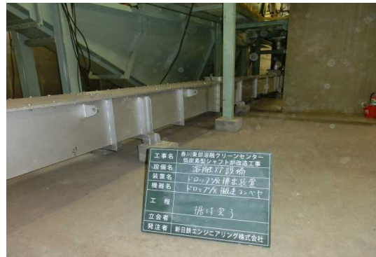
写真 47 ドロップ灰搬送コンベヤ
