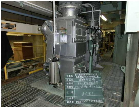
写真 48 ドロップ灰排出2重シールドダンパ
