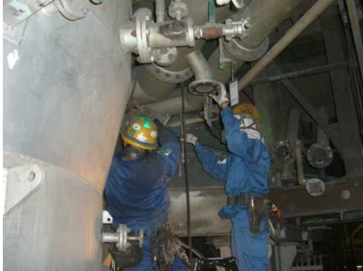
写真 1 炉廻り配管解体
