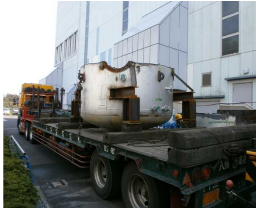
写真 20 解体炉搬送
