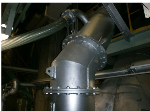
写真 44 副資材シュート
