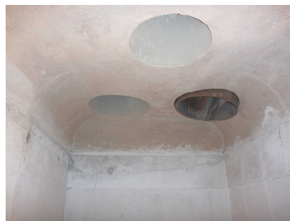
写真 51 耐火物乾燥後の炉内 （炭化物供給装置上部）
