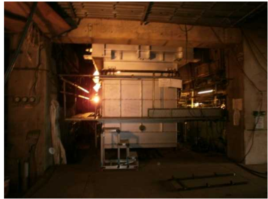
写真 38 上部・本体肌合わせ・地組み
