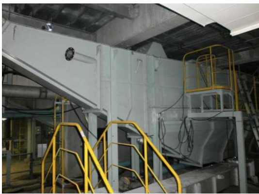
写真 29 地下機器据付完了
