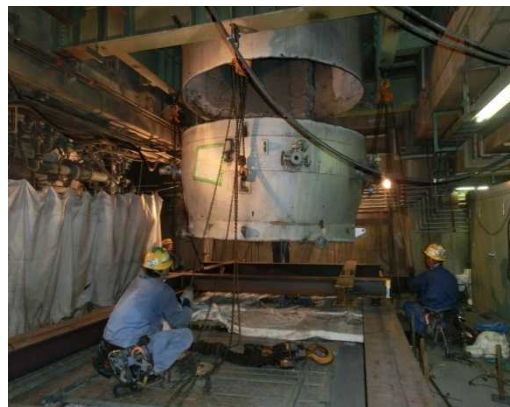
写真 16 朝顔上部解体
