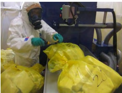
写真-5.3.12 減容化する保温材 準備(袋の縛り口 をカッターで破る)
