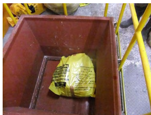
写真-5.3.30 減容化後の大サイズビニル袋の投入口への投入直後の状況
