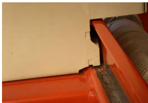
写真-3.5.13 減容化装置のボックス取付部
