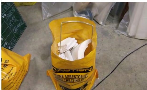
写真-3.3.4 米袋開放器具を抜き始めた状況
