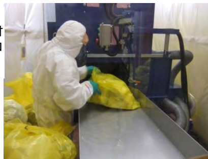
写真-5.3.13 保温材(4体)を減 容化装置投入、減 容開始開始(スイッ チのみ)
