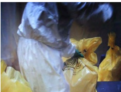
写真-5.3.18 受入用の大ビニル 袋の口を縛って梱 包する
