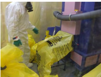
写真-5.3.16 受入用の大ビニル 袋への排出状況を 確認
