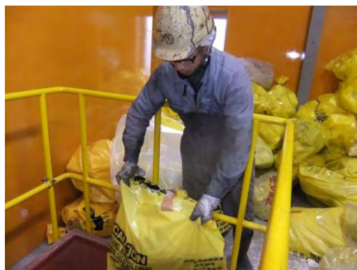
写真-5.3.29 減容化後の大サイズビニル袋の投入口への投入状況
