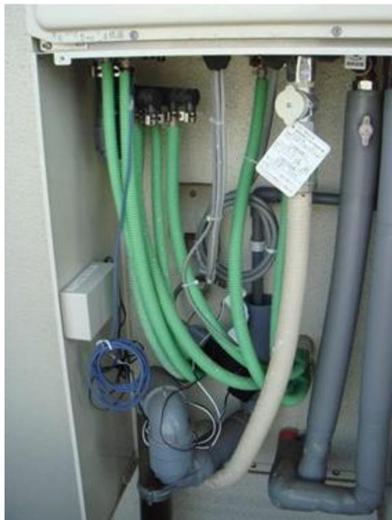
図6 給湯機用子機の設置状況
