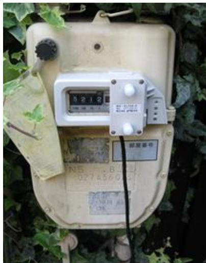
図8 ガス流量計測器の設置状況
