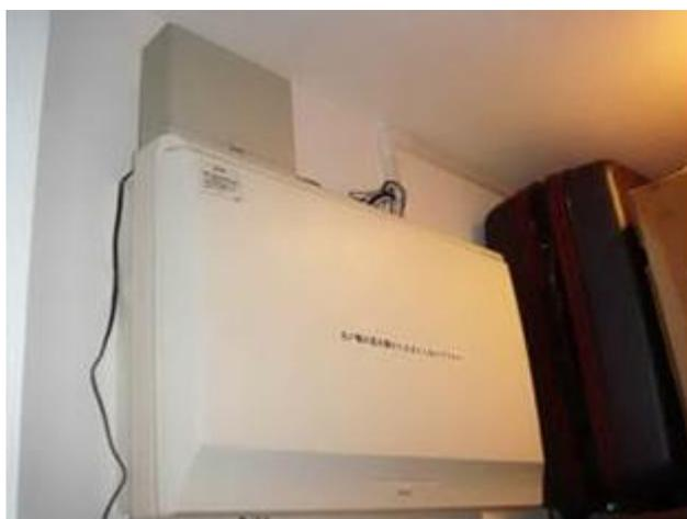
図5 計測器設置後の分電盤（分電盤上部の箱が分電盤用子機）
