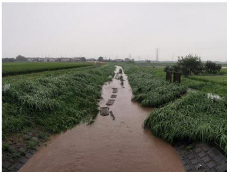
図(2)-12 2011年8月26日の里川再生装置の状況
