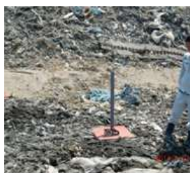
図40 沈下板の設置
