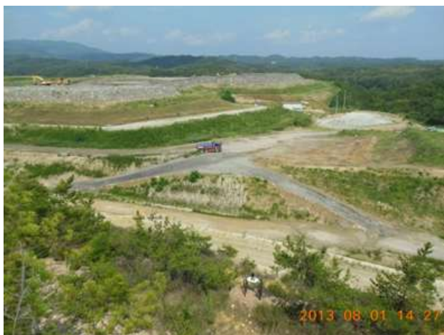
図37 継続的沈下計測を行った中部①現場
