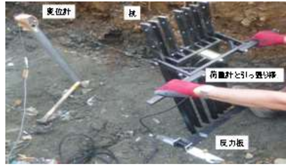
図 57 現場土圧試験実施状況
