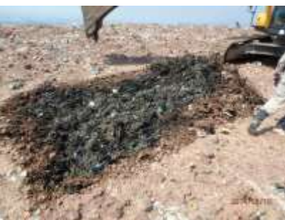
図 16 トルコ現場 (Sanitary Landfill)
