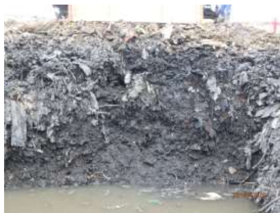
図 47 注水後の断面 （断面からほぼ一様に水が浸み出している）
