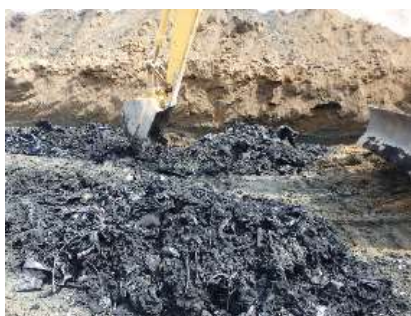
図 9 関東①現場 (安定型処分場)
