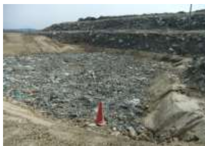
図39 沈下計測場所(沈下板設置前)
