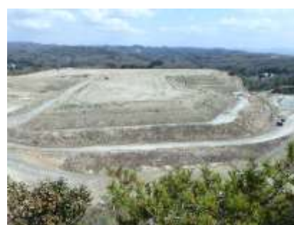
図 11 中部①現場 (安定型処分場)
