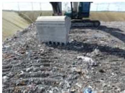
図 12 中部②現場 (管理型処分場)
