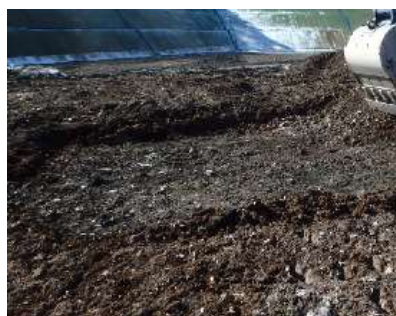
図 10 関東②現場 (管理型処分場)
