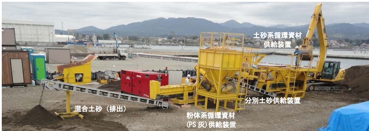
写真 6 分別土砂と循環資材の原位置混合状況
