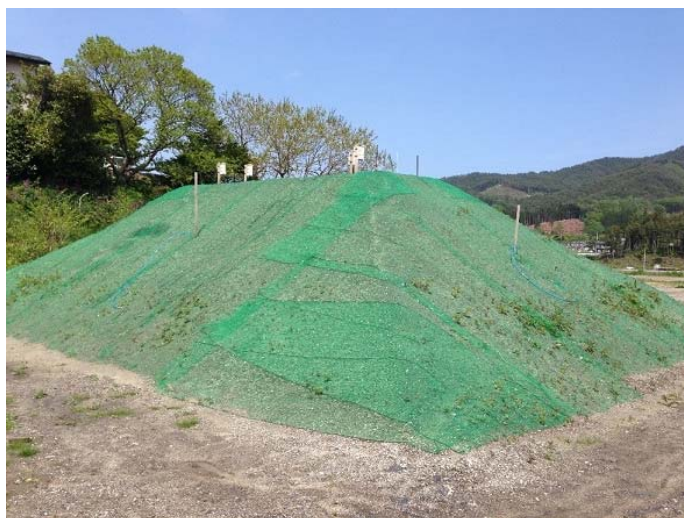
写真5 施工完了後の様子
