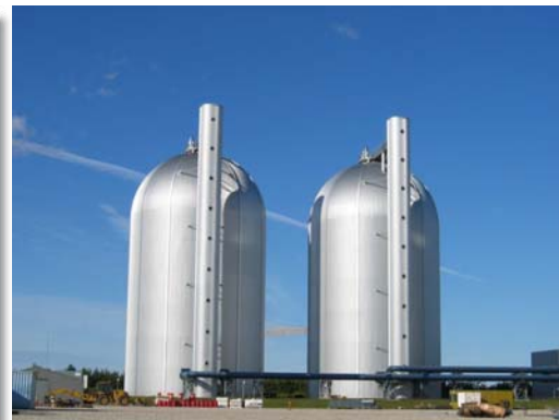
図(2)-2 コージェネレーション発電所併設の巨大貯湯槽
