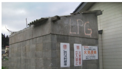
(a) 波形スレート板の破損が確認できる事例 (b) 押出成形板が多量に散在している事例
