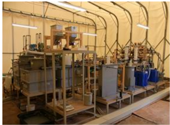
写真2 プラント内部
