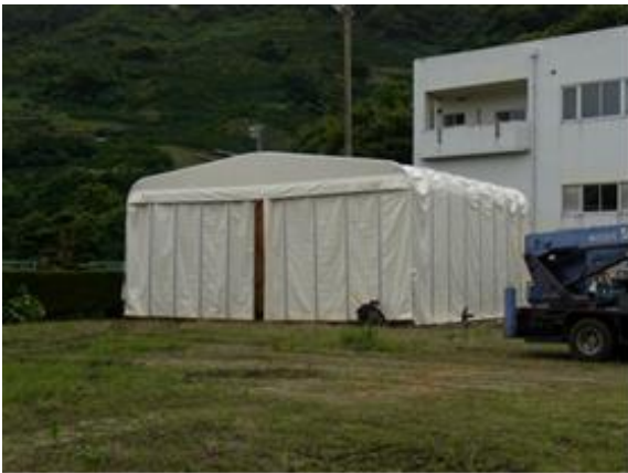
写真1 プラント外観（8m×10m）
