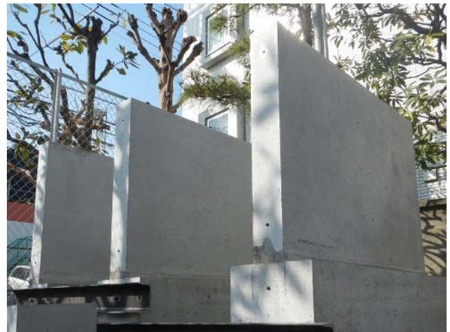
写真 3.3.2 長期暴露実大壁試験体の暴露状況
