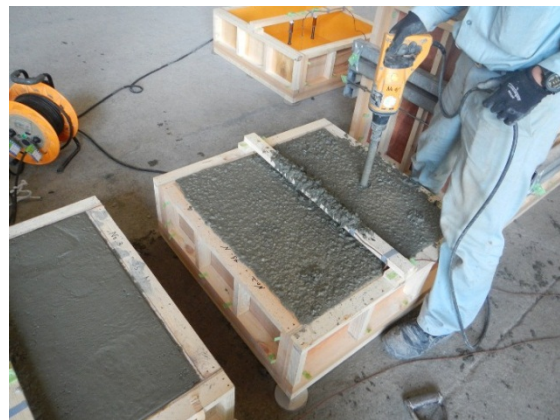
写真 3.4.4 部材製作実験の打設状況
