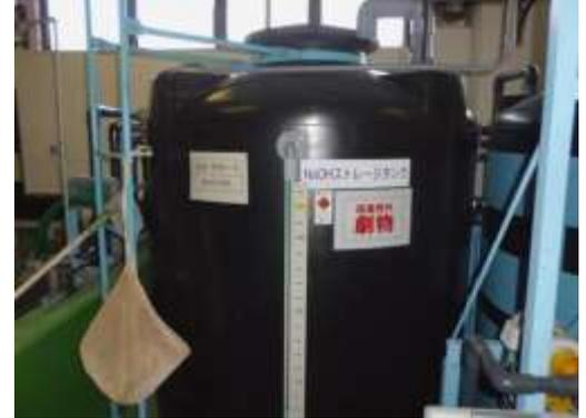
薬品タンク(水酸化カルシウム水溶液)
