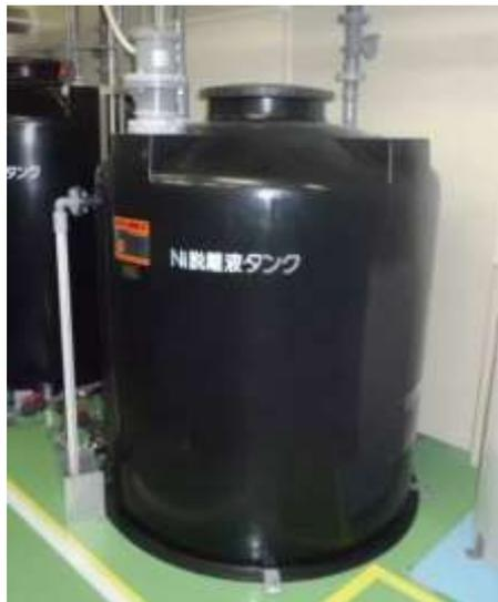
A4 Ni スラッジ生成 沈降処理槽
