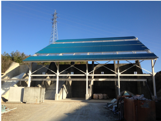
図 2 : 原料受け入れヤード（屋根付き）
