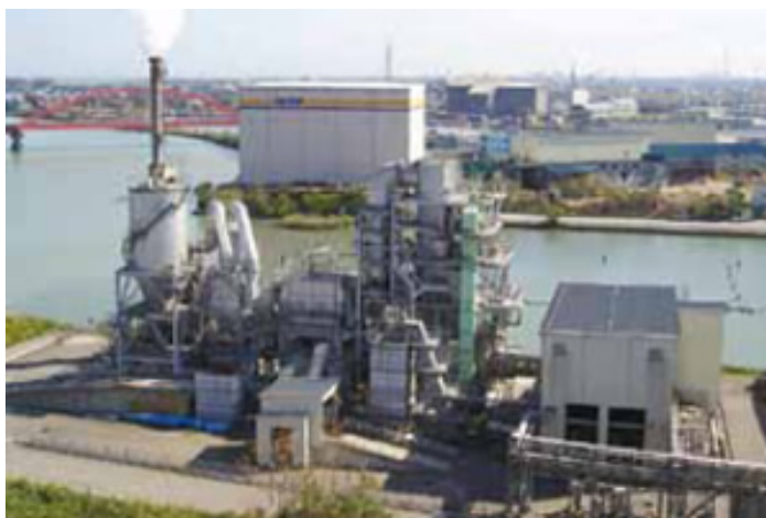
Fig.18 最終ペーパースラッジ焼却炉
