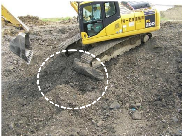
写真 3.1.2-1 A 埋立地における固結した焼却灰
