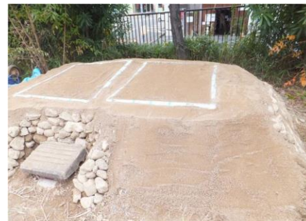
写真-5.1 施工手順の様子
