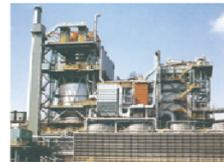
1000℃の高温コークスを不活性ガスで乾式冷却することによりコークス副熱を回収し発電
