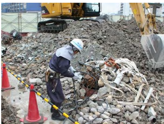
a) 解体工事における選別作業
