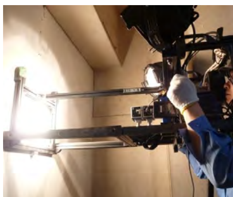
a) 壁材検査
