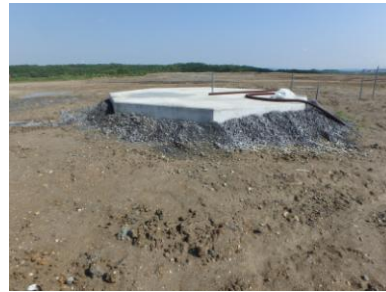
廃棄物地盤上のコンクリート基礎(径7m, 厚さ1m)
