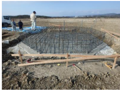
廃棄物地盤上のコンクリート基礎(径7m, 厚さ1m)
