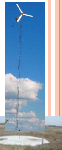
小型風力発電設備 h=30m (Excel10 by TenArrows)
