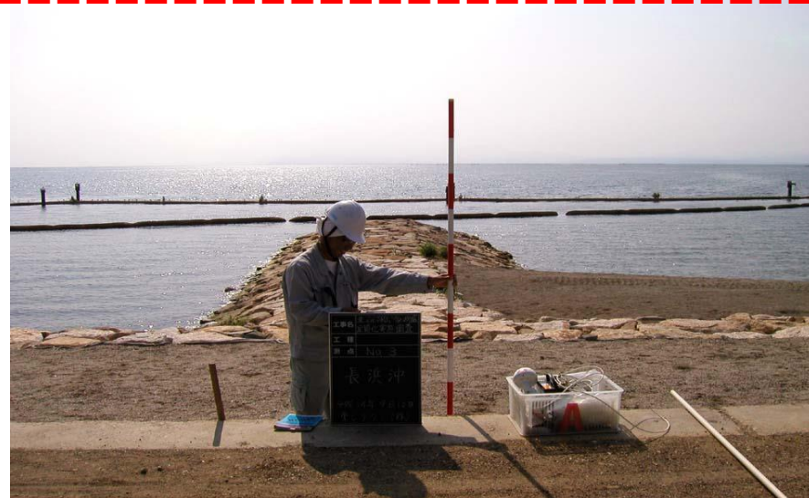
人工的護岸帯 長浜湖岸側線
