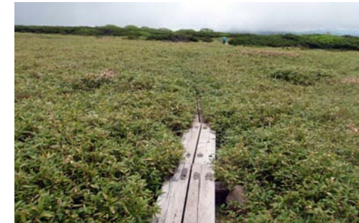
設置後10年間でササに覆われた木道
