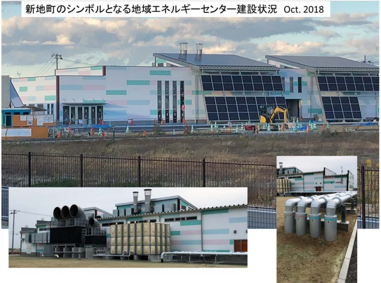
図 16 新地町の復興拠点事業地域エネルギーセンターの整備状況
