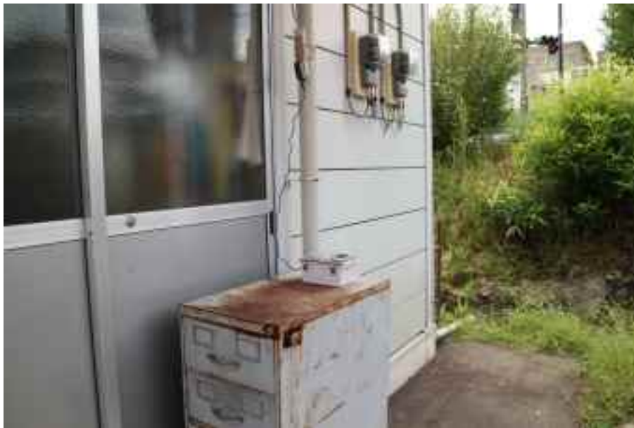
図 17 実際に設置されたセンサーユニット
