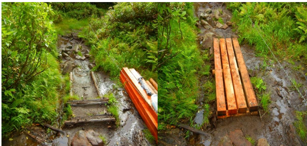
図 1-9 高原温泉における登山道補修の写真（左：補修前，右：補修後）
