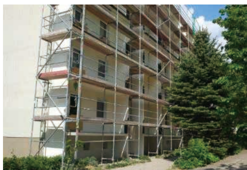
バルコニー新設工事中
