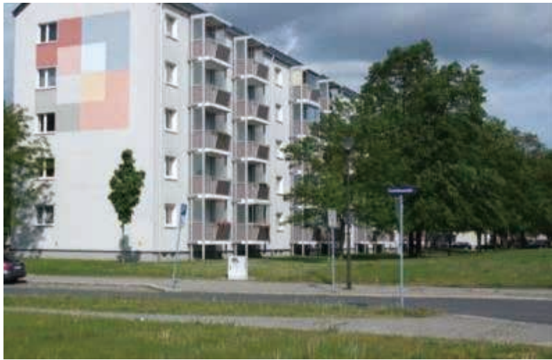
改修されたプレハブ形式の集合住宅（高さは5階建まで）
