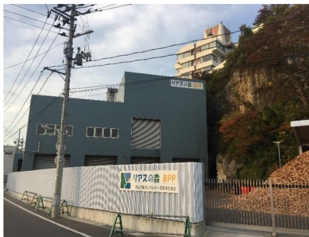
図4-2-3a. 気仙沼地域エネルギー開発株式会社の発電・熱供給プラント *右上のホテル等に熱供給を行っている。
