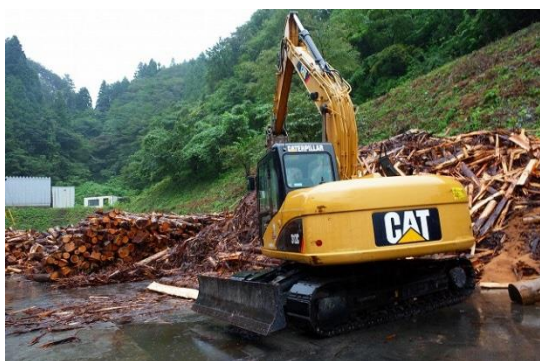
写真 7-6e. 木質ペレット工場周辺：材木は工場周辺に野ざらしにされている
