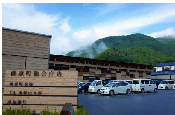
写真 7-6c. 町内産の木材で建設された橿原町総合庁舎の外観
