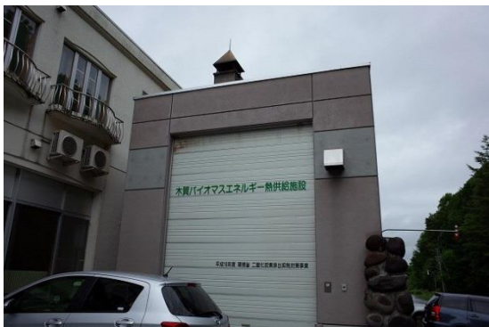
写真 7-2b. 五味温泉のバイオマスボイラー
