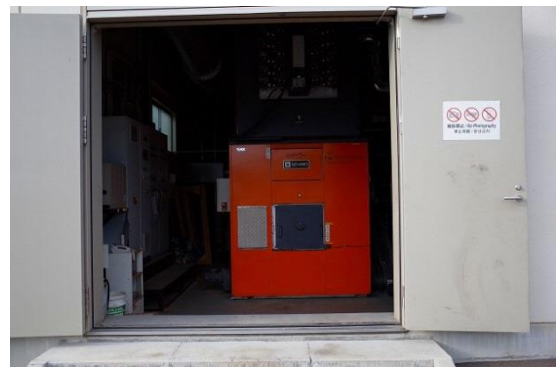
写真 7-2c. 熱供給のためのバイオマスボイラー：町内に11基配置されている
