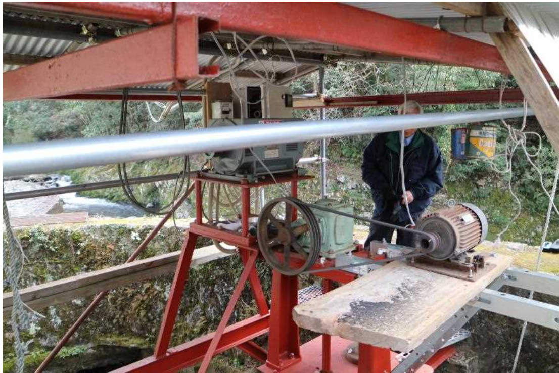
図 61. 水車の上に取り付けられていた発電装置
