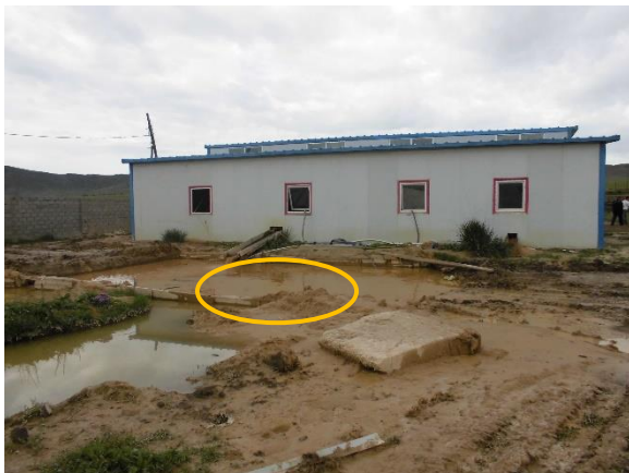
写真 32 水銀を使用しない選鉱場外観と尾鉱採取位置（円内）
