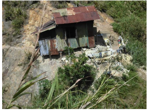
写真 36 バトンプハイにおける作業
