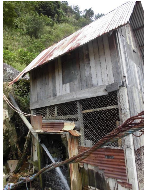
写真 38 水力で運転するミル
