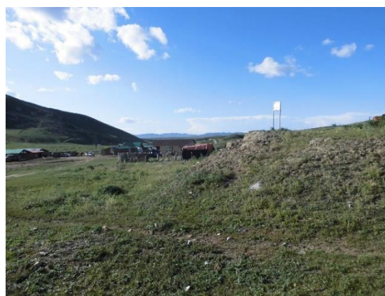
写真 31 左記の尾鉱の一部を回収、運搬、再堆積し、「自然化」した現場。
