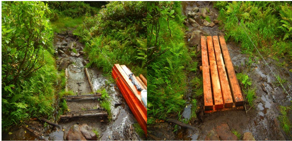
図1-10 高原温泉における登山道補修の写真(1) (左：補修前、右：補修後)
