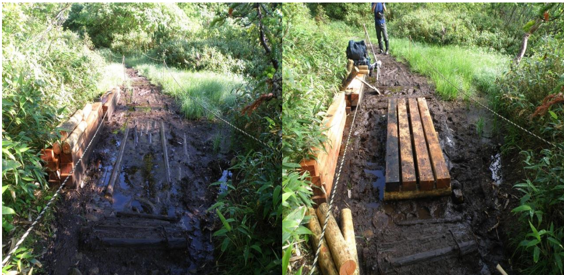
図1-11 高原温泉における登山道補修の写真(2) (左：補修前、右：補修後)
