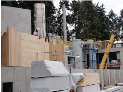
写真4 建設中の施設 (UBC)
