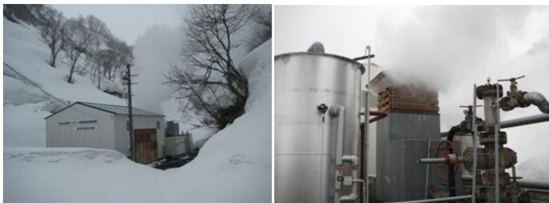
図 48 松之山温泉バイナリーサイクル発電設備概観
