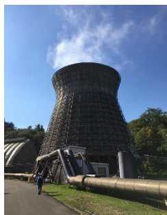
▲松川地熱発電所
