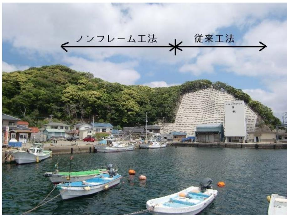
図 35 ノンフレーム工法施工斜面と従来技術施工斜面の景観の比較
