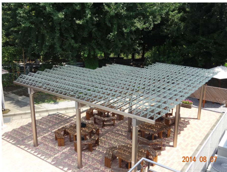
図 42 エアリーシェードの施工時例 出所) 積水化学工業株式会社
