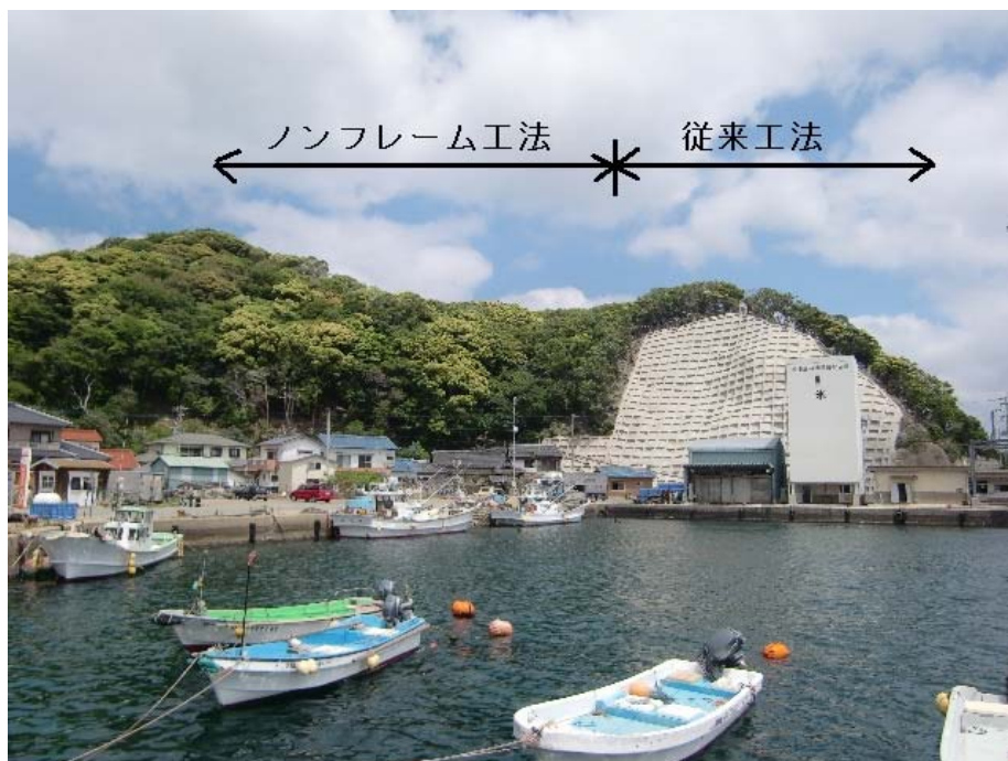
図 35 ノンフレーム工法施工斜面と従来技術施工斜面の景観の比較 出所) ノンフレーム工法研究会
