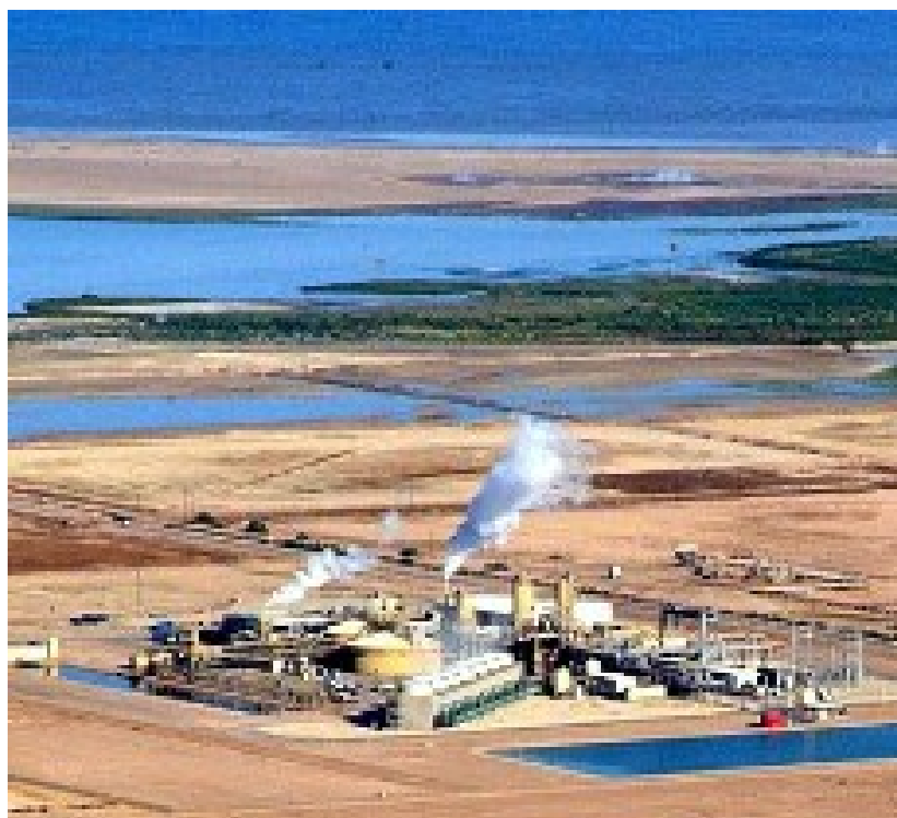
図表 3 -26 Hudson Ranch I 地熱発電所
