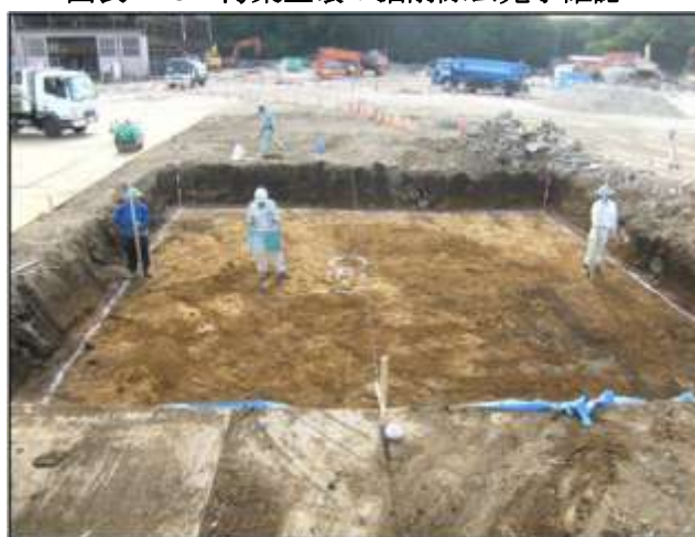
図表 213 汚染土壌の掘削除去完了確認
