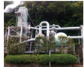
自家用では国内最大規模となる杉乃井ホテルの地熱発電所
