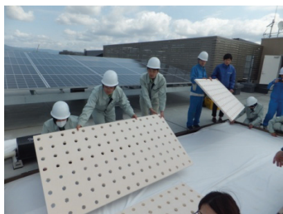
屋上での作業の様子
