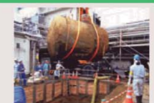
地下タンク撤去
