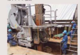
遮水壁延長工事
