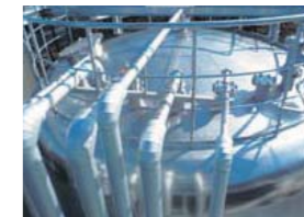
清浄レベルごとに回収した水を200トンのタンクに貯蔵し再利用
