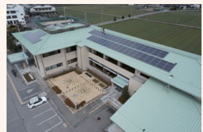
写真3-2-7 ひがしおうみ市民共同発電所3号機の太陽光パネル
