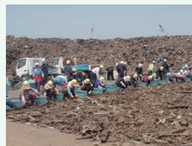
写真2-2-5 手作業で進められた 震災廃棄物の分別作業
