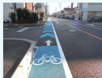
写真4-1-1 市道28号線に整備した自転車専用通行帯（平成26年整備）
